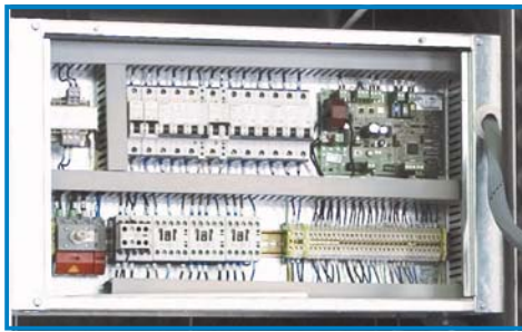
Quadro elettrico modulare Modular electrical cabinet
